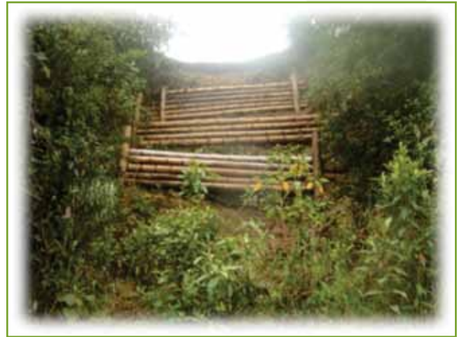
Construcción de trinchos, Vereda La Hoya, Calera Programa INAP 2011
