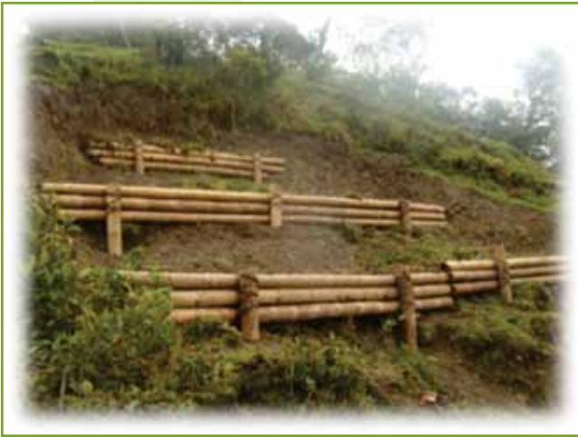
Construcción de trinchos, Vereda La Hoya, Calera Programa INAP 2011
