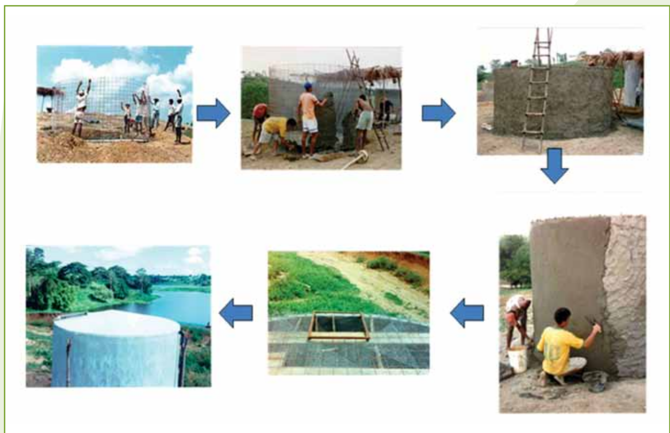
Proceso de construcción del tanque en ferrocemento
