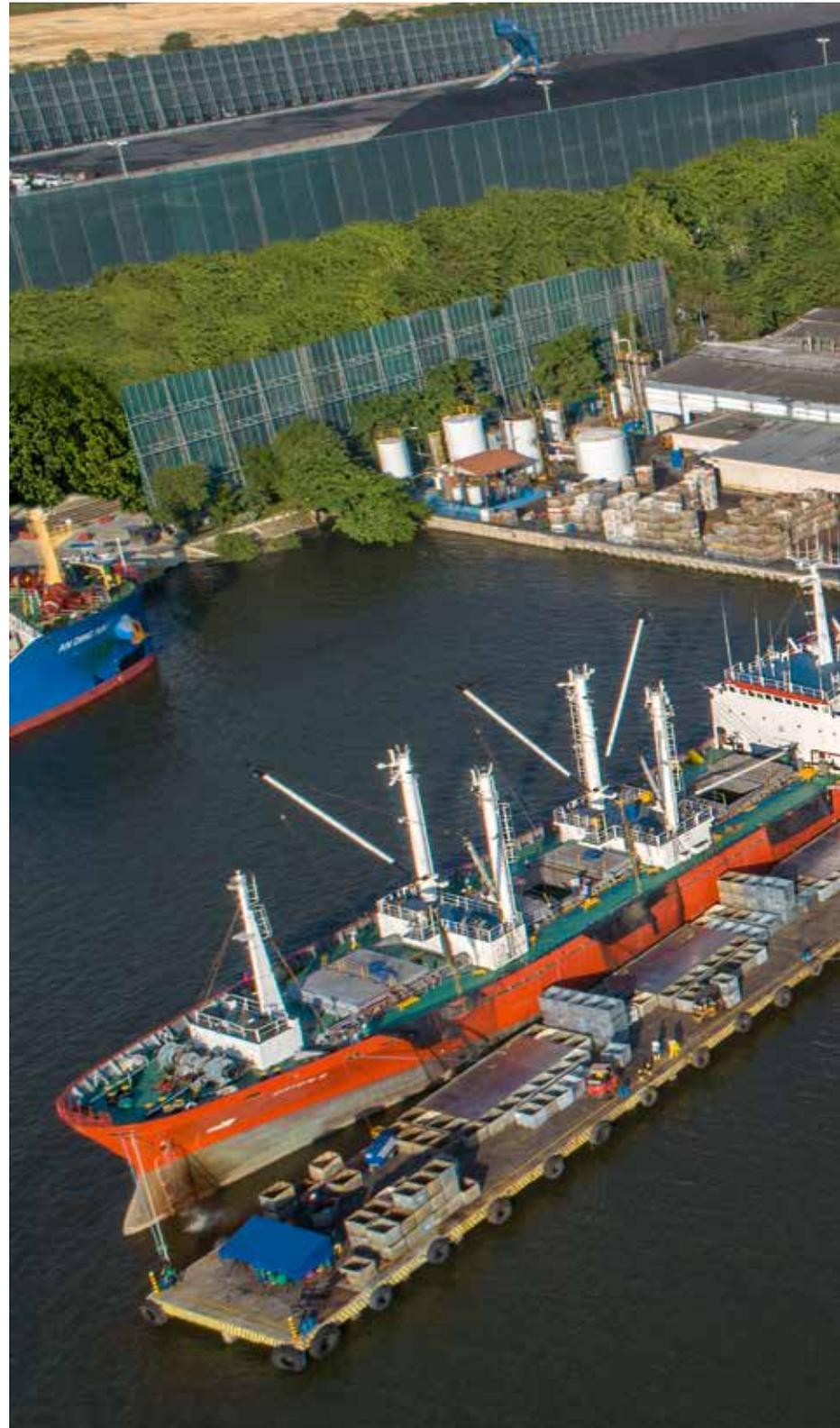
En la zona donde funciona la planta de procesamiento se construyó un muelle de 130 metros de largo por 15 metros de ancho, que permite la descarga de cuatro barcos de forma simultánea. También se construyeron varias edificaciones en un área que supera los 19.000 m<sup>2</sup>.
